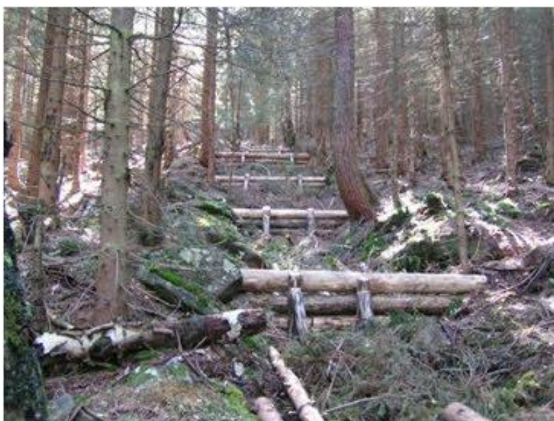
Przegrody drewniane wypełnione gałęziówką na szlakach zrywkowych
